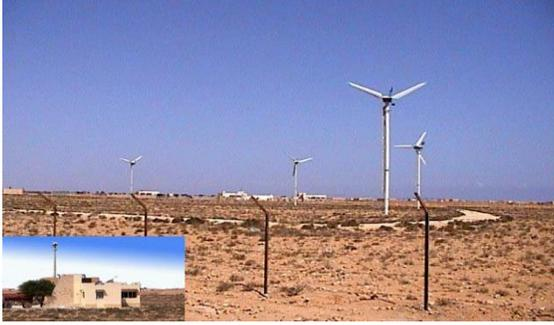
(شكل ٦) وحدة رياح قدرة ٢٥ كيلووات هولندية الصنع ذات ريش خشبية بقطر ١١ متر مركبة على برج اسطوانى ارتفاعه ١٥ متر
